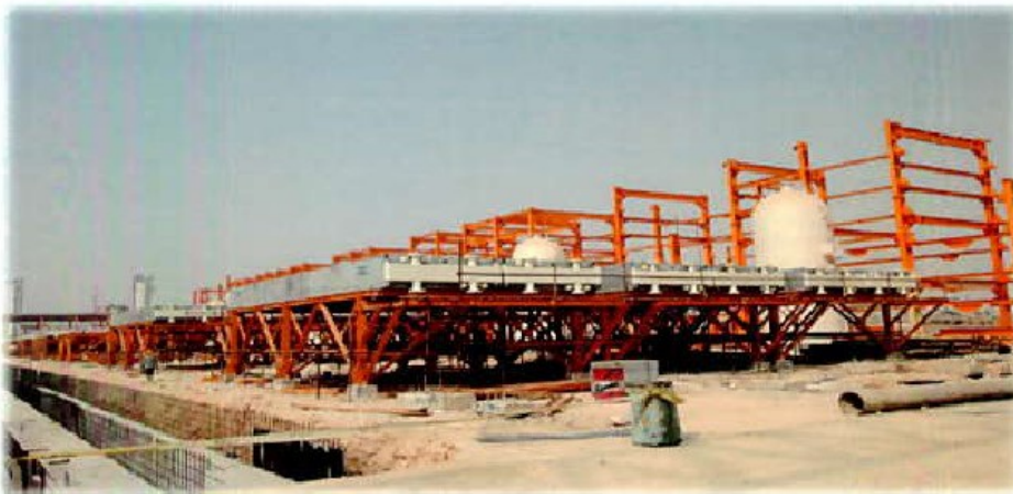
عملیات Piperacks نامیه 5- عسلویه
