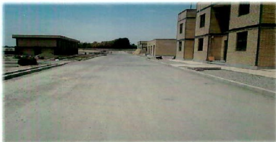
تصفیه خانه شهر قدس تهران - EPC
