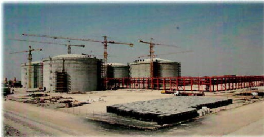
پروژه امداد مفازن فاز 15 و 16 عسلویه - EPC
