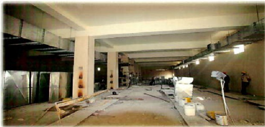
عملیات سافتمان SS-1 نامیه 5- عسلویه
