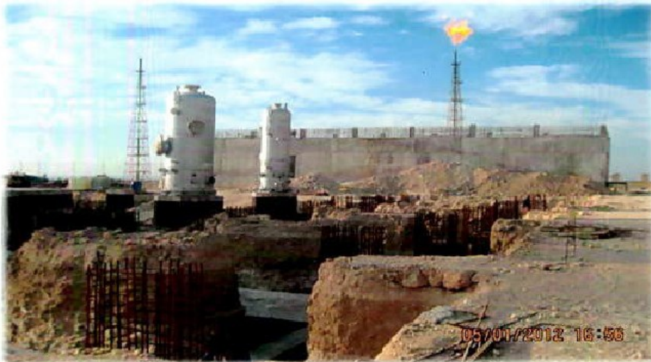
پروژه امداد ایستگاه تقویت فشار گاز درود 1 و 2- فارک
