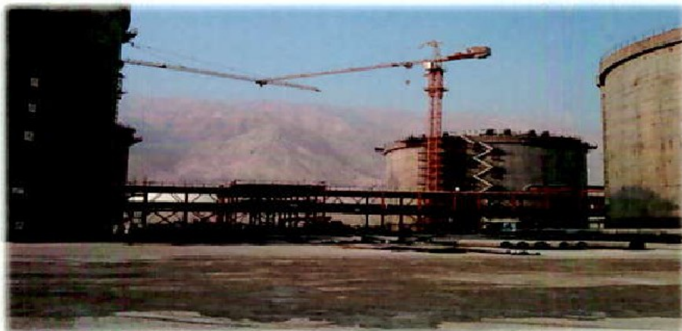
پروژه احداث مخازن فاز 17 و 18 عسلویه - EPC
