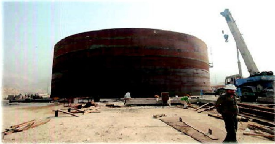
امداد مخزن ذخیره آب آنتی‌شکافی - عسلویه
