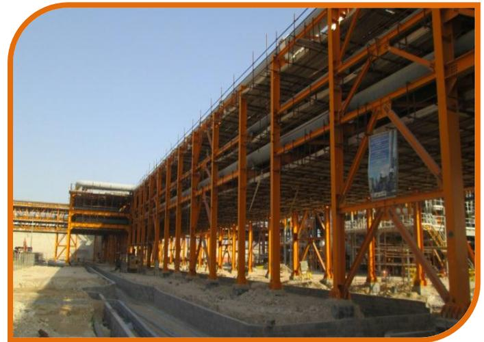
عملیات ساخت و نصب پایپینگ ، ساپورت ، استراکچر و Pump Column مخازن LPG و نصب تجهیزات مکانیکی فازهای ۹-۱۰ پارس جنوبی
